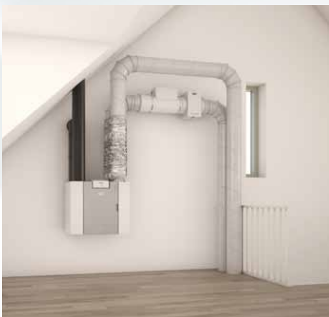
De Pure induct wordt direct na het ventilatietoestel geïnstalleerd.
